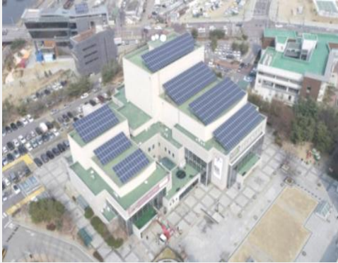
오산 문화예술회관 태양광설비공사
