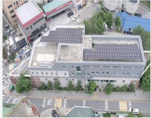
고양시 종합복지관 태양광발전설비
